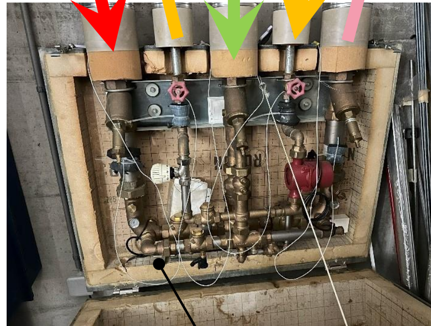
Mischwasseranlage
