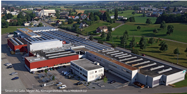
Seven-Air Gebr. Meyer AG, Klimagerätebau, Werk Hitzkirch LU
