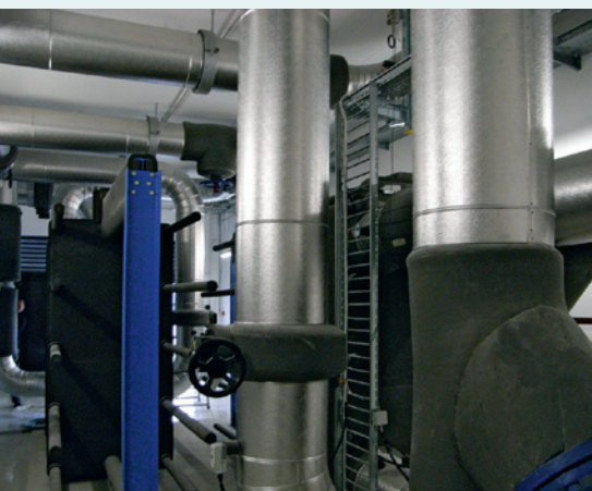
Free Cooling im RZ ermöglicht eine einfache Effizienzsteigerung. Foto M. Achermann
